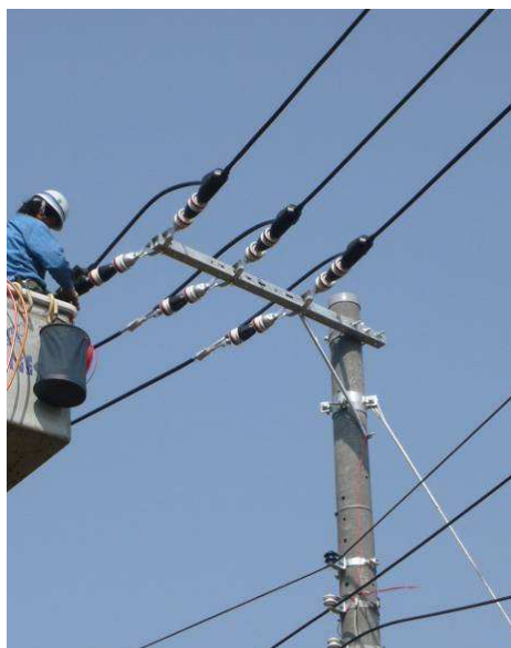
図3 リサイクルOC電線の布設状況
